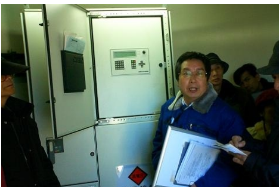
風車の支柱の中
